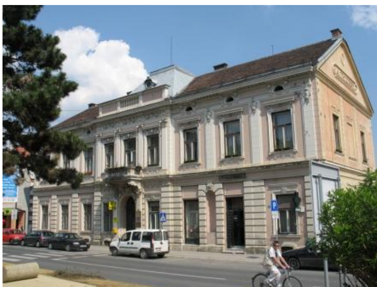
Slika 51. Zgrada stare gradske ljekarne - Pregrada
