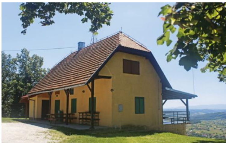
Slika 11. Planinarska kuća Kunagora
